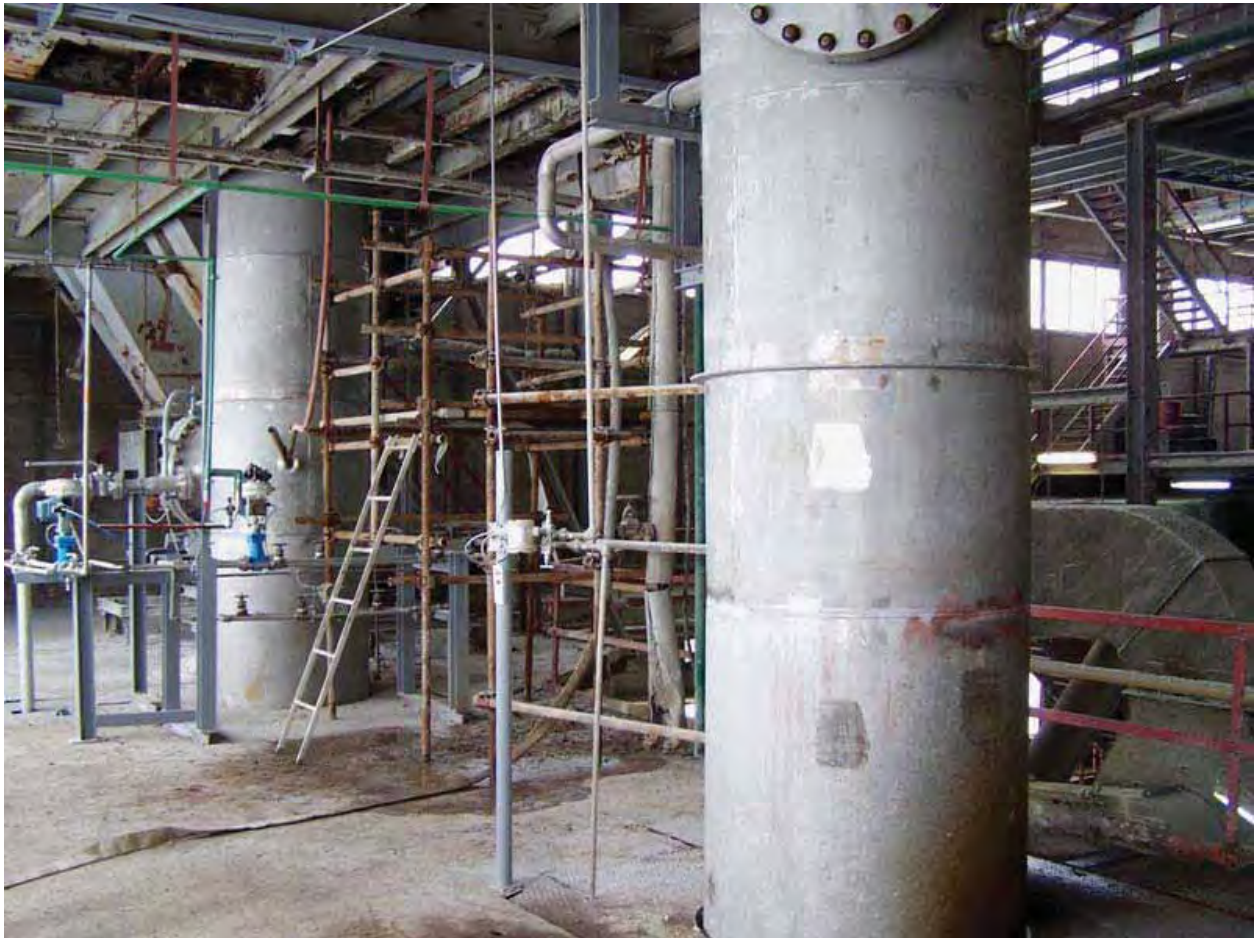
Slika 2. Apsorpcijske kolone, alkalna i kisela na postrojenju NPK 1 čija se ugradnja dovršava.
