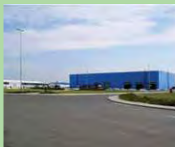
DALEKOVOD- CINČAONICA, d.o.o. Dugo Selo
